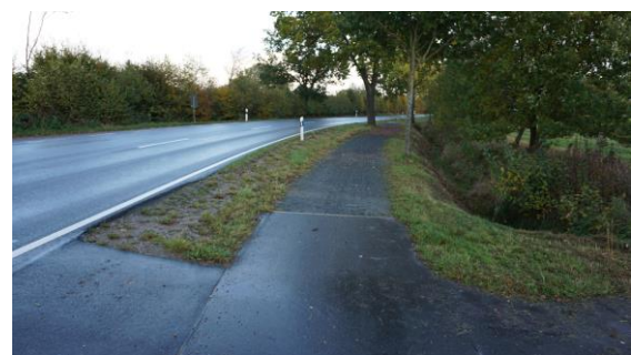
Nach der Straßensanierung neu hergestelltem Radweg mit wassergebundener Decke an der L80 westlich von Oering
