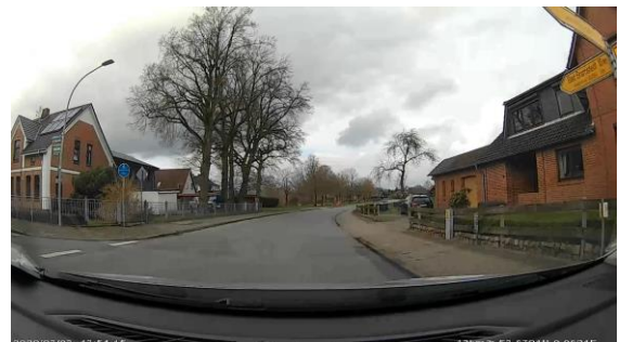
Gemeiner Geh- und Radweg im Zweirichtungsverkehr innerorts in Schmalfeld
